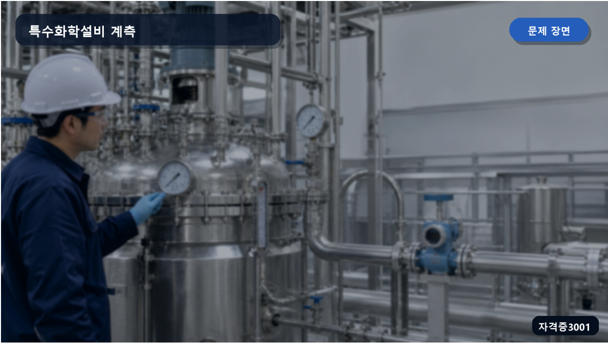
특수화학설비 반응기와 배관에 온도·유량·압력 계측기가 설치된 장면
